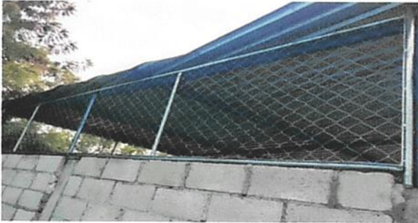
Foto 3: Terminación de malla.
