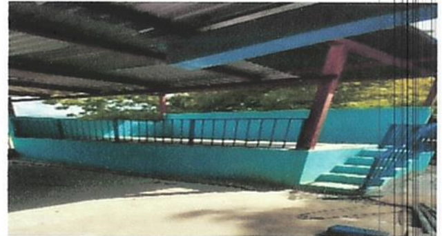
Foto 2: Terminación de baranda de seguridad del escenario.
