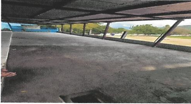
Foto1: Finjalización la losa de concreto de 0.08 cms.
