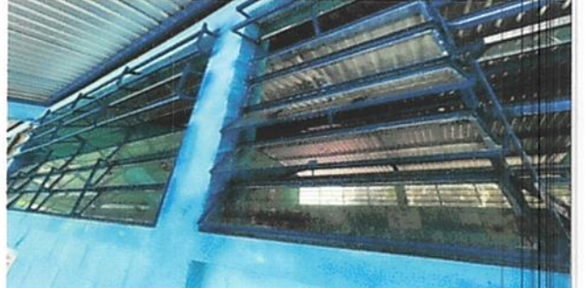
Foto 4: Concluyendo con los vidrios ya cambiados.
